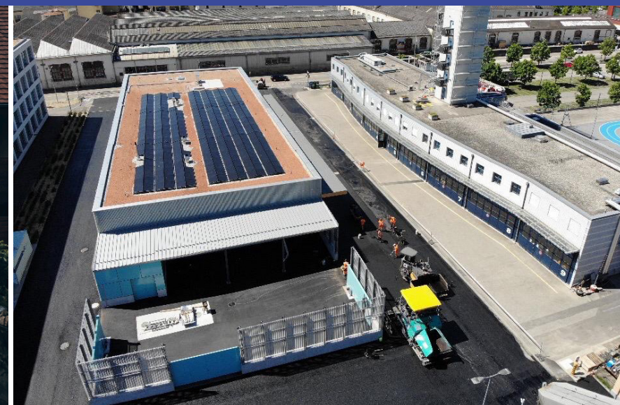
POSE D'ENROBÉ À LA CASERNE SDIS, YVERDON-LES-BAINS
