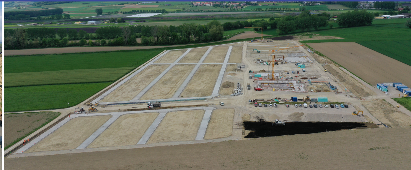
CHEMINS BÉTON, PÉPINIÈRES MEYLAN, YVERDON-LES-BAINS
