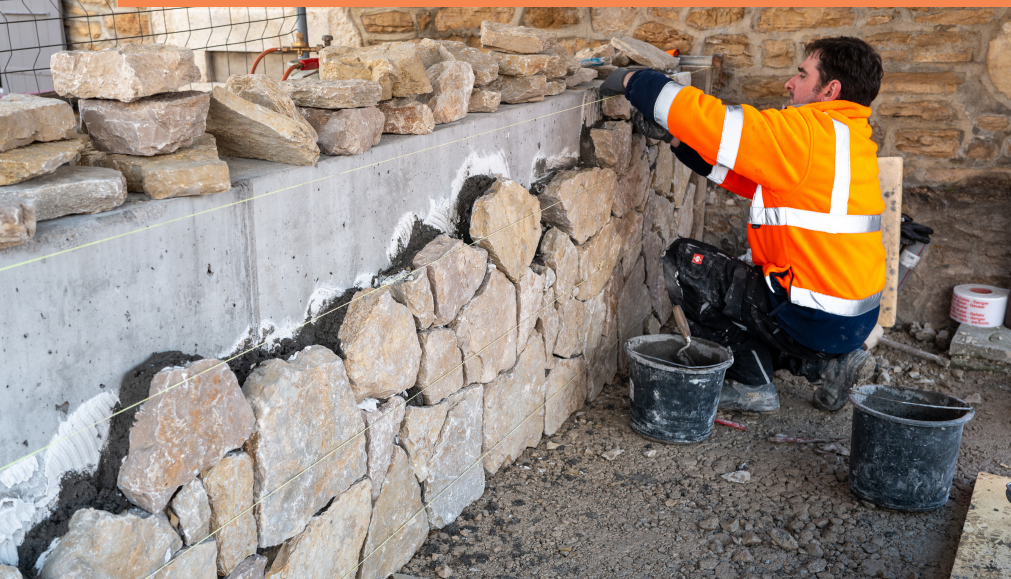
MURETS EXTÉRIEURS EN BRIQUE RUSTIQUE
