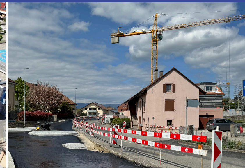
POSE D'ENROBÉ, ESSERTINES-SUR-YVERDON
