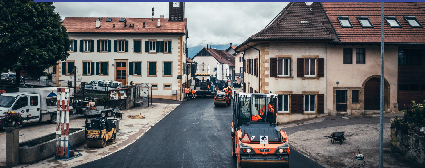
POSE D'ENROBÉ, BELMONT-SUR-YVERDON
