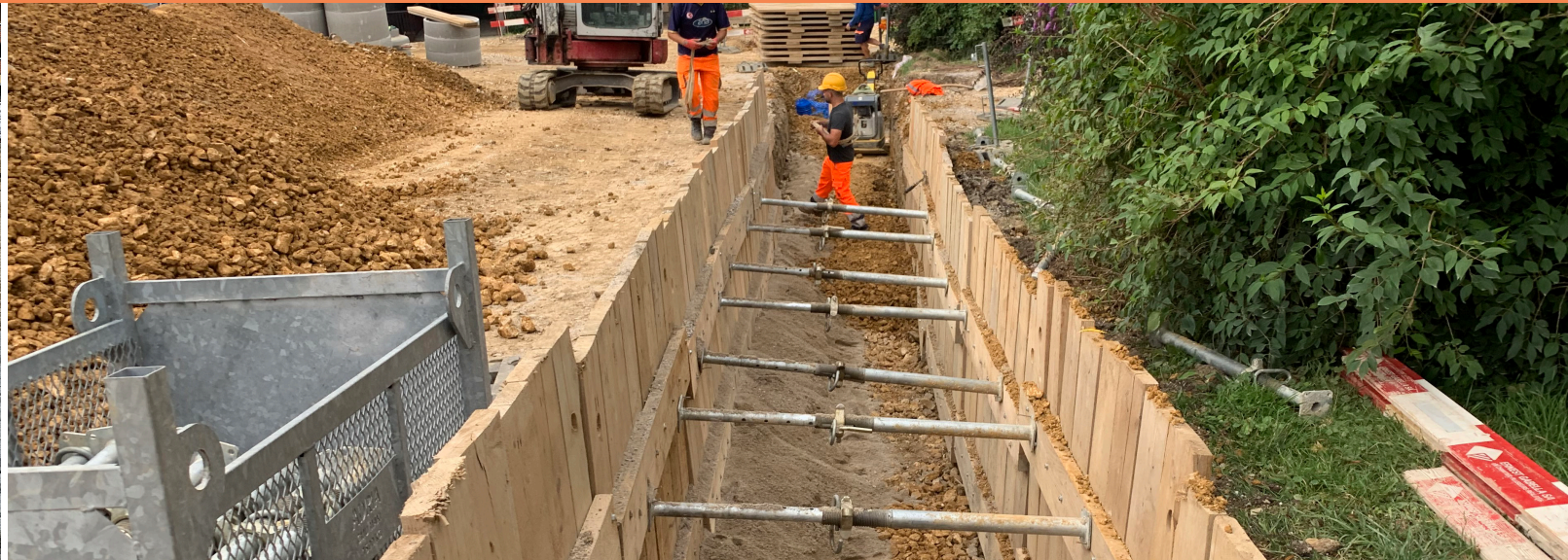
MISE EN SÉPARATIF, TÉVENON
